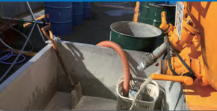
吸引剥離作業後に貯めていたダンパー車タンクから汚水を受水槽に送水 ①・②
